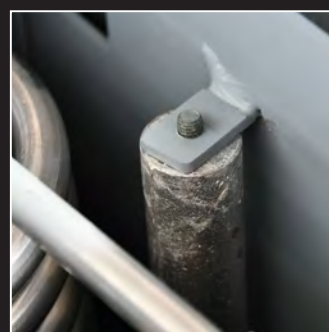
Magnesium-Schutzanode zum Schutz des Heizkessels
